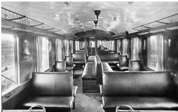
Fabriksfoto fra Scandia fra 1926, da vognen blev bygget. I midten af vognen langsædet, hvorunder motoren ligger
